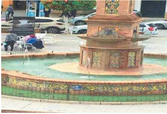
Plaza del Ayto.: Fuentes bien cloradas y con recirculación
